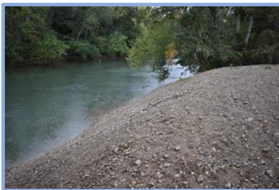
Merlon d'injection localisé en rive droite de l'Adour sur la commune de Saint-Sever – 40500 (crédit photo : Fabien Boutault)
