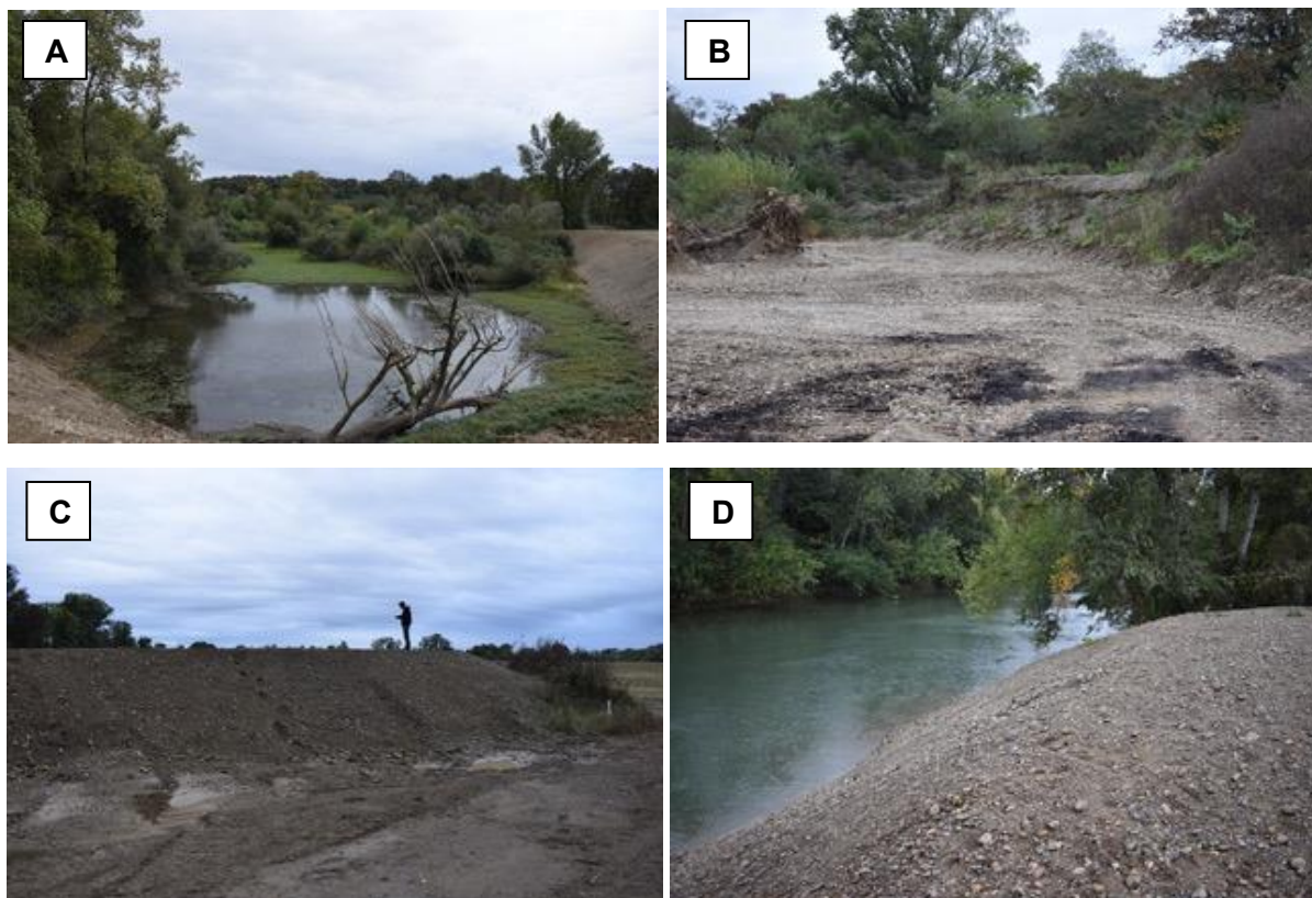
Figure 3. Photographies A : Zone humide recréé sur l'ancien site d'extraction, B : Zone d'expansion des crues, C : Merlon de protection de la zone d'expansion des crues et D : merlon de sédiments injectés en aval du seuil d'Augreilh (Crédit photo : Fabien Boutault)
